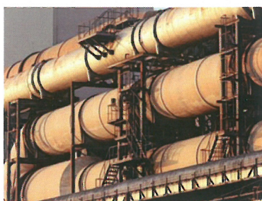
■ 配管 (ダクト) 内部
