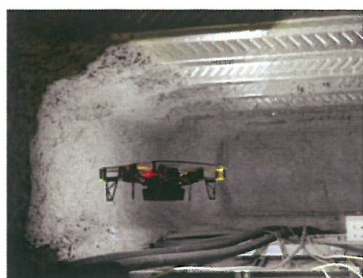
■ 天井裏・地下ピット
